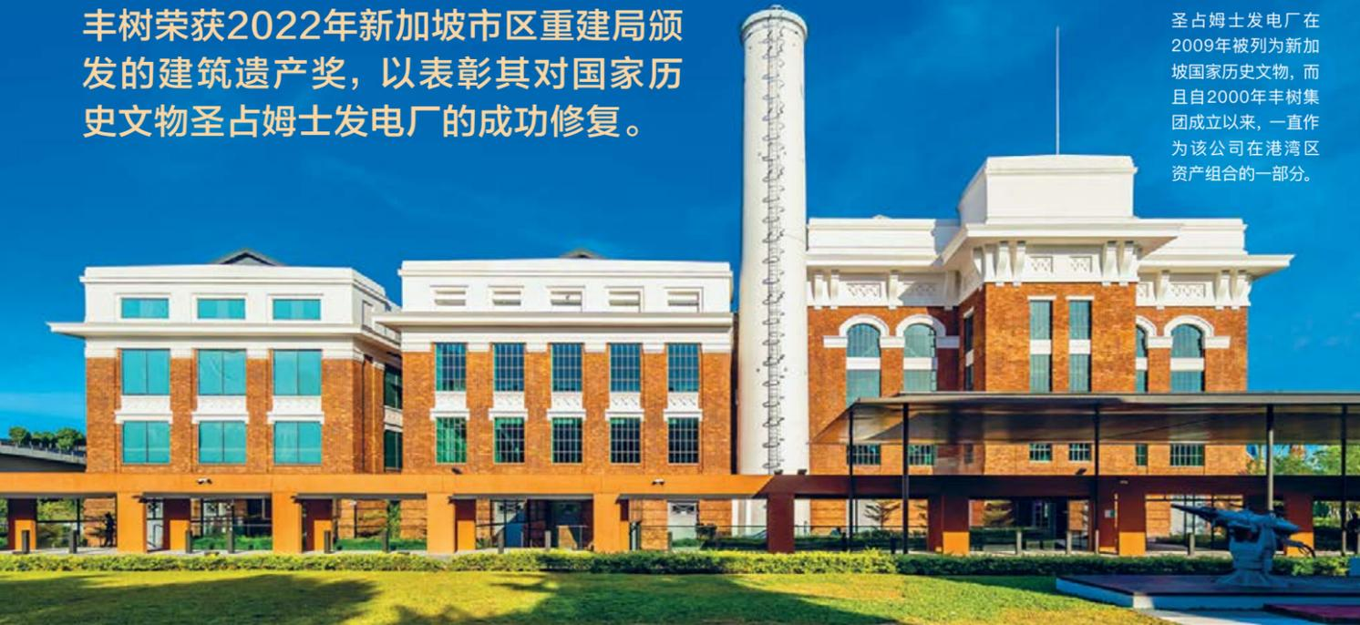
通过参考档案照片，将历史悠久的木门和窗户小心拆除，然后进行异地修复。建筑外立面的缺失部分，包括枕梁和壁架，被小心翼翼地修复如初。对圣占姆士发电厂的修复让这座近百年老建筑重焕生机，也令丰树获颁2022年保护与创新奖(市区重建局建筑遗产奖的一部分)。丰树亦将可持续性融入设计与建筑物的运营中，彰显了集团将可持续发展实践纳入其业务的承诺。
